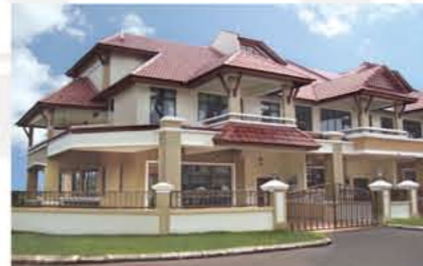
Type B Double Storey Terrace 双层排楼 22' x 70' - 5 Bedrooms 卧室 Built-up area 建筑面积: 2,540 - 3,535 sq.ft. 平方米
